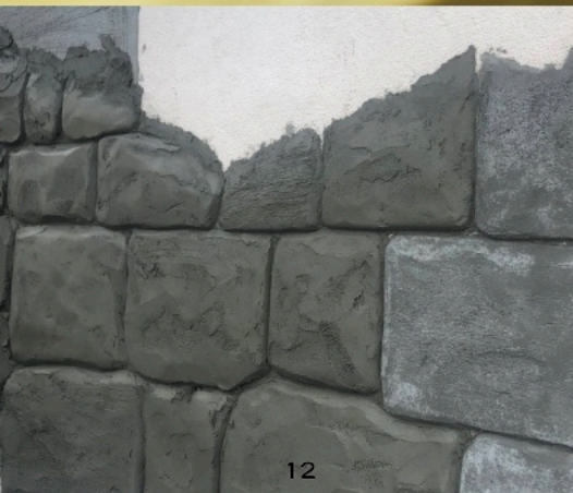
7 モールテックスは水をはじく特性を持つ 8 モールテックス仕上げの無機質な階段 9 カラーバリエーションが豊富なモールテックス 10 照明による陰影が楽しめる引きずり仕上げの漆喰壁 11 カラフルなビニールストーンや砕いた貝殻を骨材にしたポップな研ぎ出し仕上げ 12 石積みを表現した施工中のモルタル造形
