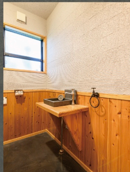
左. 和のモルタル造形を玄関土間に施した。昔ながらのグリ石で基礎を造ったかのような表現をしている。中. 折り上げ天井も左官仕上げ。赤茶色は福島の土、やや緑がかっているのは京都の土。その回りを珪藻土が囲んでいる。右. トイレの壁は珪藻土のフシ引き仕上げ。床には炭が練り込んである。
