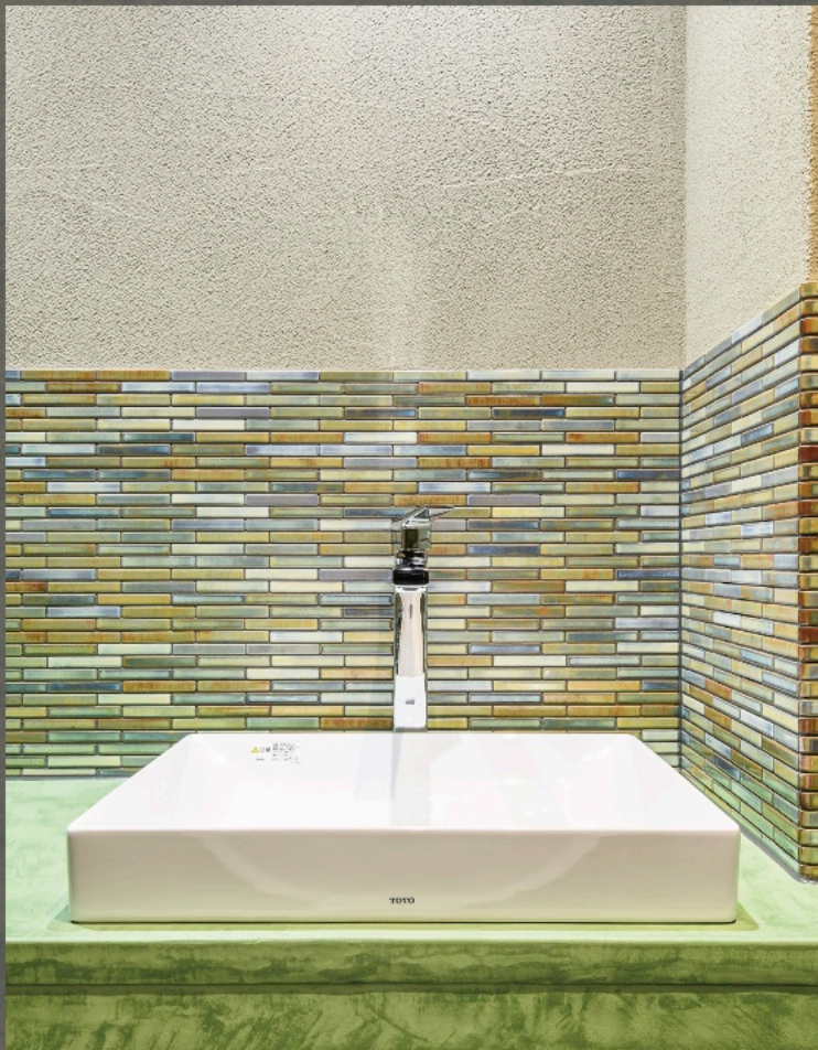
上・下写真、トイレのカウンターとミニキッチンカウンターそれぞれに色の違うモルテックスを施工。コンクリートのような質感が得られモザイクタイルとの相性もいい
