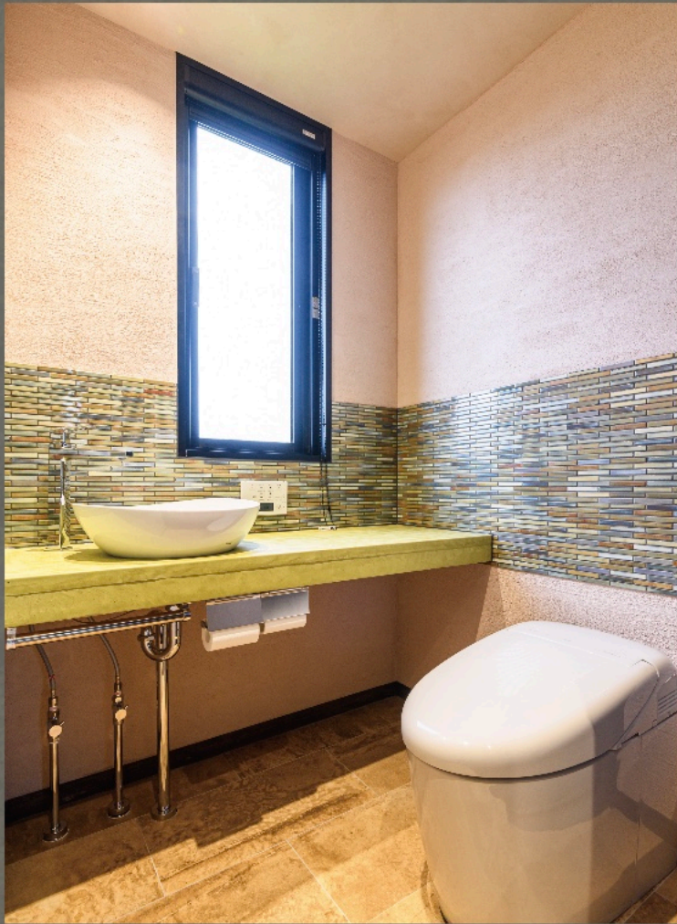
上・下写真、トイレのカウンターとミニキッチンカウンターそれぞれに色の違うモルテックスを施工。コンクリートのような質感が得られモザイクタイルとの相性もいい
