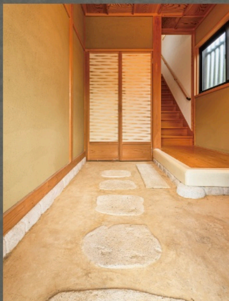
左. 和のモルタル造形を玄関土間に施した。昔ながらのグリ石で基礎を造ったかのような表現をしている。中. 折り上げ天井も左官仕上げ。赤茶色は福島の土、やや緑がかっているのは京都の土。その回りを珪藻土が囲んでいる。右. トイレの壁は珪藻土のフシ引き仕上げ。床には炭が練り込んである。
