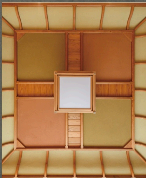
左. 和のモルタル造形を玄関土間に施した。昔ながらのグリ石で基礎を造ったかのような表現をしている。中. 折り上げ天井も左官仕上げ。赤茶色は福島の土、やや緑がかっているのは京都の土。その回りを珪藻土が囲んでいる。右. トイレの壁は珪藻土のフシ引き仕上げ。床には炭が練り込んである。
