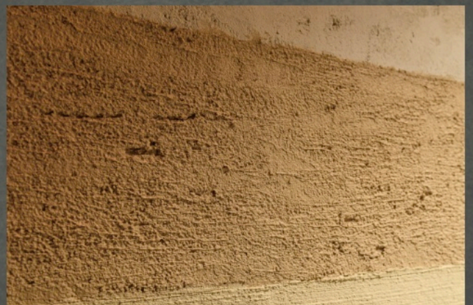
桐生の土を用いた土壁で地層を表現した塗り版染仕上げ。栃木県葛生の石灰を配合して色合いの差を出している
