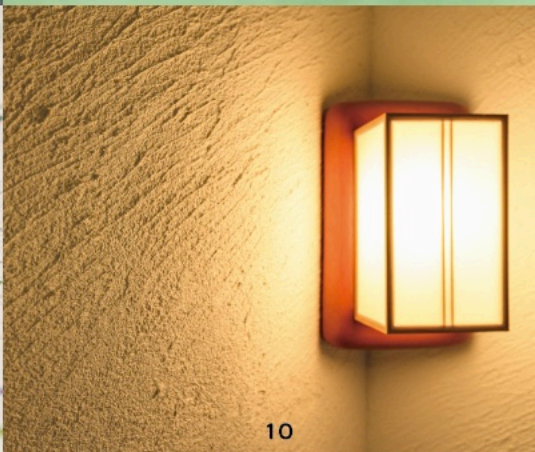
7 モールテックスは水をはじく特性を持つ 8 モールテックス仕上げの無機質な階段 9 カラーバリエーションが豊富なモールテックス 10 照明による陰影が楽しめる引きずり仕上げの漆喰壁 11 カラフルなビニールストーンや砕いた貝殻を骨材にしたポップな研ぎ出し仕上げ 12 石積みを表現した施工中のモルタル造形
