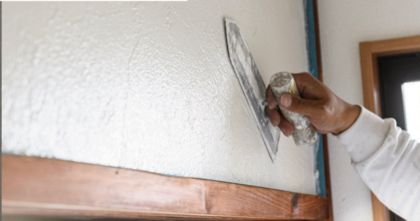
左官職人がコテを使って手際よく壁面に漆喰を塗っていく
